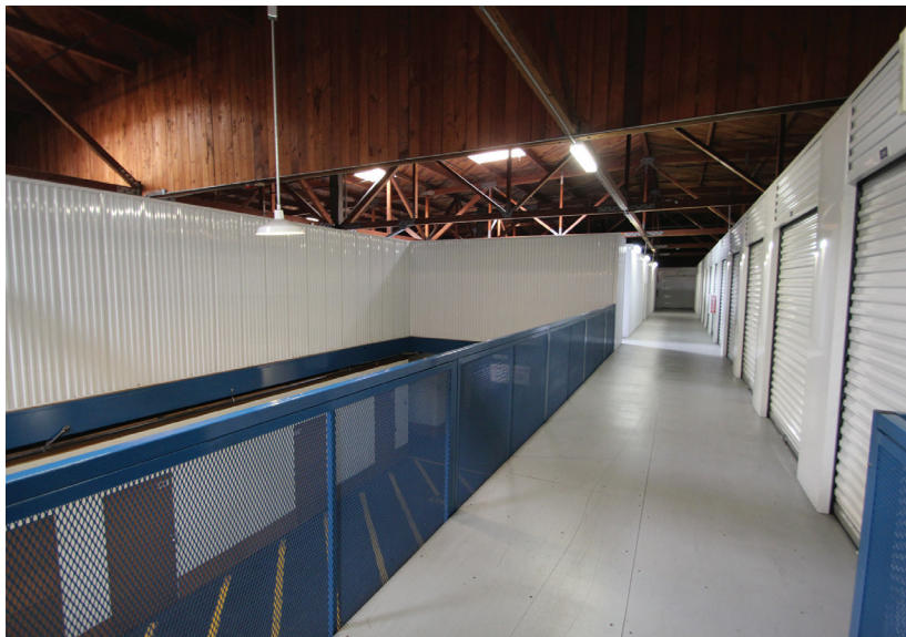
Após 13 anos operando, os painéis ResinDek® no 2º andar ainda estão ótimos no Central Self-Storage.
